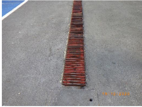
รูปที่ 2-47 ตะแกรงดักขยะมูลฝอยในบ่อตรวจสอบการระบายน้ำ
