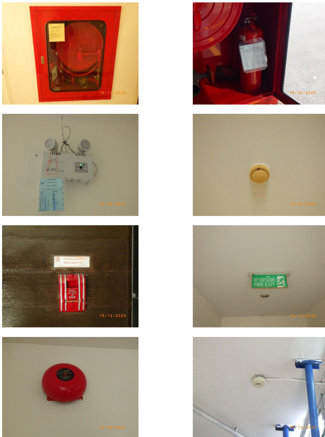
รูปที่ 2-31 ระบบป้องกันอัคคีภัย และระบบแจ้งเหตุเพลิงไหม้
